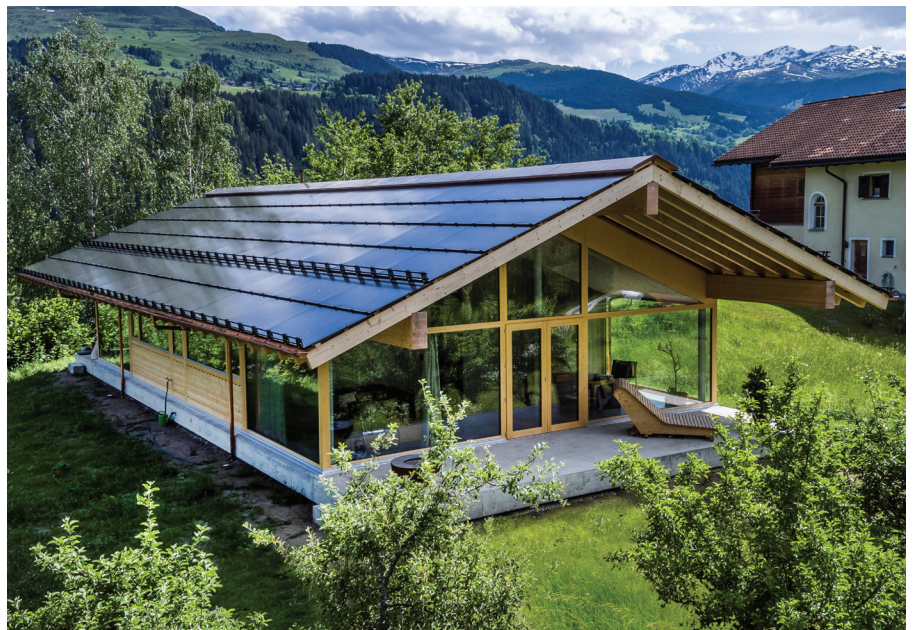
Abb. 1: 817%-PEB Brunner-BapstWaltensburg/GR (Energiebedarf 4'900 kWh/a, Stromproduktion 40'100 kWh/a)
