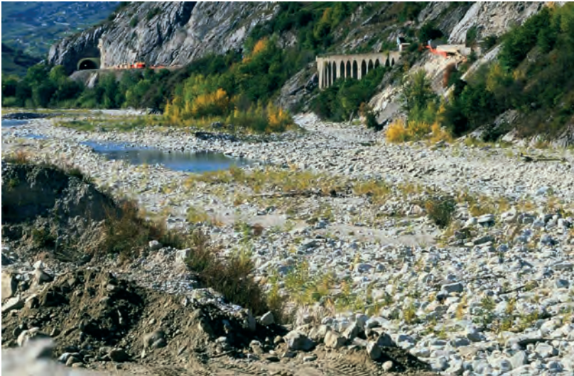
Abb. 15: Rotten bei Mörel/VS von den Rhonekraftwerken extrem genutzt (Bild: SGS 2008).
