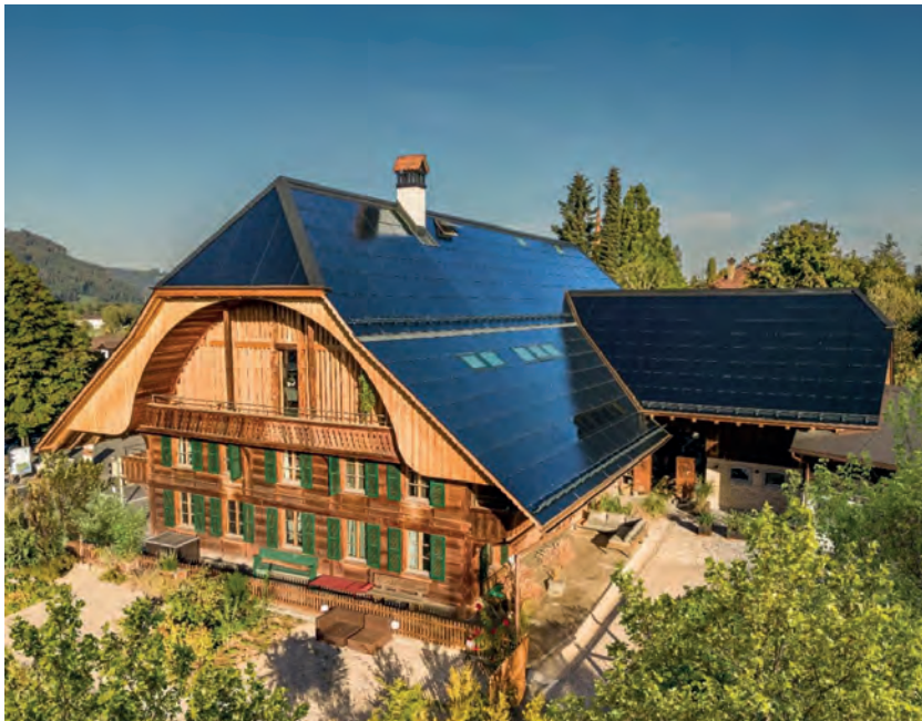
Abb. 42 Das von 2021 bis Herbst 2022 sanierte denkmalgeschützte PEB-MFH in Münsingen/BE ist ein Musterbeispiel dafür, wie ein historisches Gebäude saniert werden kann. Dank guter Dämmung und einer perfekt ins grosse Walmdach integrierten PV-Anlage stieg der Gesamtenergiebedarf von 20'165 kWh/a vor der Sanierung trotz vielfach grösserer Wohnfläche nur auf 55'350 kWh/a. Es wird ein jährlicher Energieertrag von 78'400 kWh/a erreicht, was eine Eigenenergieversorgung von 142% bedeutet.
