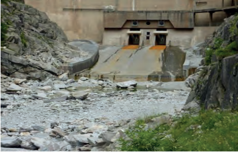
Abb. 17: Nach der Staumauer des Massastausees/VS lassen die Electra Massa SA im Widerspruch zu Art. 76 Abs. 3 BV kein Restwasser fließen (Bild SGS, Sommer 2009).
