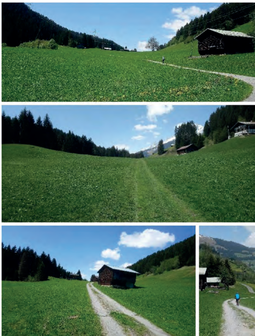
Abb. 55: Bestehender Meliorationsweg Migliè in Waltensburg. Die vor Jahren durchgeführte Melioration in Waltensburg erstellte diesen heute noch gut funktionierenden Meliorationsweg; finanziert wurde er von Bund und Kanton sowie von Privaten. Im Sommer dient dieser auch als Wander- und Veloweg zwischen Waltensburg und Breil.
