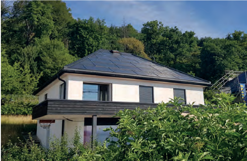
Abb. 43: Das 1936 in Neuenburg/NE erstellte Einfamilienhaus konsumierte vor der Sanierung rund 26'900 kWh/a. Dank der Dämmung konnte der Gesamtenergiebedarf um 80% auf 5'200 kWh/a reduziert werden. Die vorbildlich ganzflächig integrierte 17,8 kWp-PV-Anlage erzeugt 16'700 kWh/a und erreicht damit eine Eigenenergieversorgung von 321%. Für diese energetisch und ästhetisch vorbildliche Sanierung erhielt das Einfamilienhaus den HEV-Sondersolarpreis 2023.
