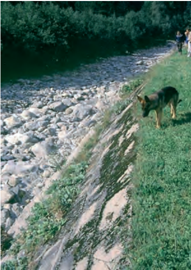
Abb. 22: Gentalwasser Oberland Ost Kt Bern von Kraftwerke Oberhasli (KWO) trockengelegt (Bild: Roth/BE).
