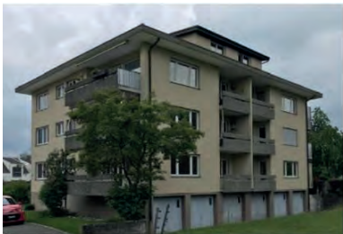
Abb. 1a: Durch die Min.P/PEB-Sanierung des 50-jährigen MFH in Fahrwangen sank der Gesamtenergieverbrauch um 82% von 138'000 kWh fossil-nuklearen Energien auf Null bzw. 25'000 kWh/a CO 2 -freien Solarstrom (Abb. 1a: EW-bestätigt, 4.7.2022).
