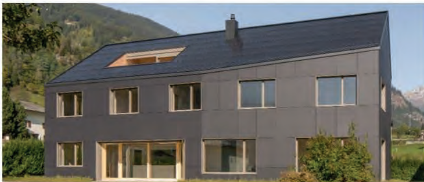
Abb. 2e: Das 600% Winter-PlusEnergieHaus konsumiert dank Minergie-P-Dämmung jährlich bloss 7'400 kWh und produziert 45'000 kWh/a. Die durchdachte Form führt zum europaweit höchsten 395%-Winter-PlusEnergieHaus (Halbjahresverbrauch: 4'800 kWh bei einer Produktion von 19'000 kWh/a). Mit dem Solarstromüberschuss von 37'600 kWh/a können 25 E-Autos jährlich je 10'000 km CO 2 -frei fahren.
