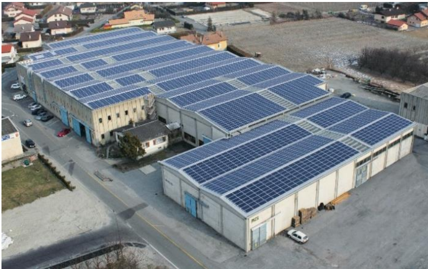
Abb. 41: Solstis SA et Joseph Carron SA ont inauguré la plus grande installation photovoltaïque du Valais, sur la toiture du dépôt d'engins à Saxon (PEB Diplom, Schweizer Solarpreis 2013/557 E-Autos jährlich) Gesamtenergiebedarf: 225'265 kWh/a (100%) Solarstromüberschuss: 779'455 kWh/a (346%) Eigenenergieversorgung: 1'004'720 kWh/a (446%)
