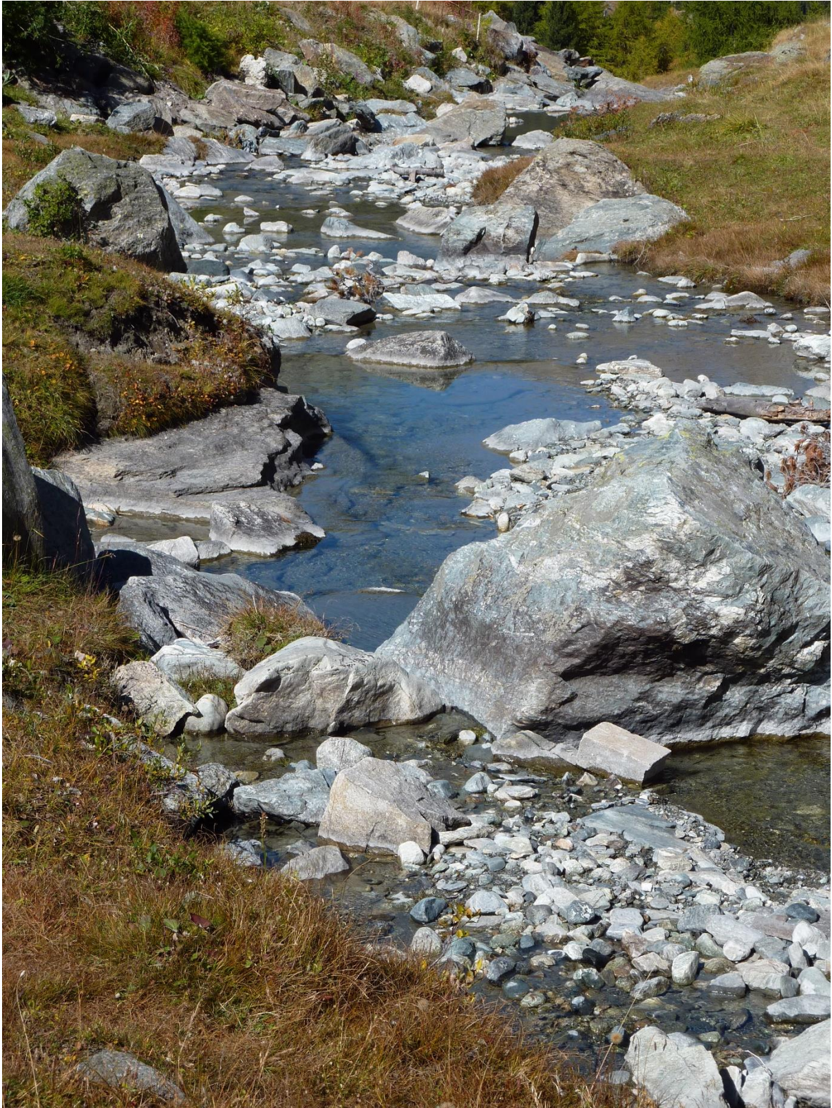
Abb. 45: Die fast trocken gelegte "La Gougra" oberhalb Grimentz im Val d'Anniviers, ein südliches Seitental des Rhônetals/VS. Das Speicherkraftwerk Gougra mit einer 164 MW-Leistung und Jahreserzeugung von 537 GWh/a nutzt die Wasserkraft aus dem Val d'Anniviers und dem Turtmantal vor allem dank der 1954 gebauten Staumauer Moiry oberhalb Grimentz. Die Staumauer ist 148 Meter hoch und 610 Meter lang. Vom Stausee aus gelangt das Wasser in die Kraftwerke in Mottec, Vissoie und Chippis (Navizence).
