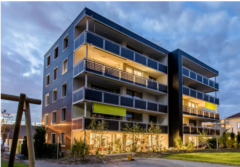
Abb. 21: PEB MFH mit 10 Wohnungen (PEB-Solarpreis 2018/14 E-Autos jährlich) Gesamtenergiebedarf: 49'241 kWh/a (100%) Solarstromüberschuss: 19'358 kWh/a (39%) Eigenenergieversorgung: 68'599 kWh/a (139%)
