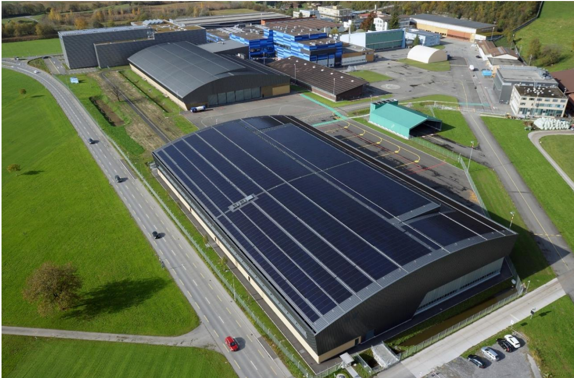
Abb. 40: PEB Pilatus Flugwerke AG in Stans/NW (Norman Foster Solarpreis 2018/90 E-Autos jährlich) Gesamtenergiebedarf: 966'666 kWh/a (100%) Solarstromüberschuss: 125'828 kWh/a (14%) Eigenenergieversorgung: 1'092'494 kWh/a (114%)
