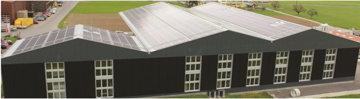
Abb. 36: Ansicht und Energiebedarf des Energieparks Gams in Gams/SG. Der produzierte Solarstrom wird vor allem von der Eigenverbrauchsgemeinschaft genutzt, die 12 Firmen umfasst. Dieser vorbildliche PlusEnergie-Gewerbepbau erhielt den Solarpreis 2018 (Werte bestätigt von der Elektro Gams Genossenschaft am 06.07.2018, Tel. 081 750 39 20; Schweiz. Solarpreis 2018, S. 36/37/249 E-Mobile jährlich).
