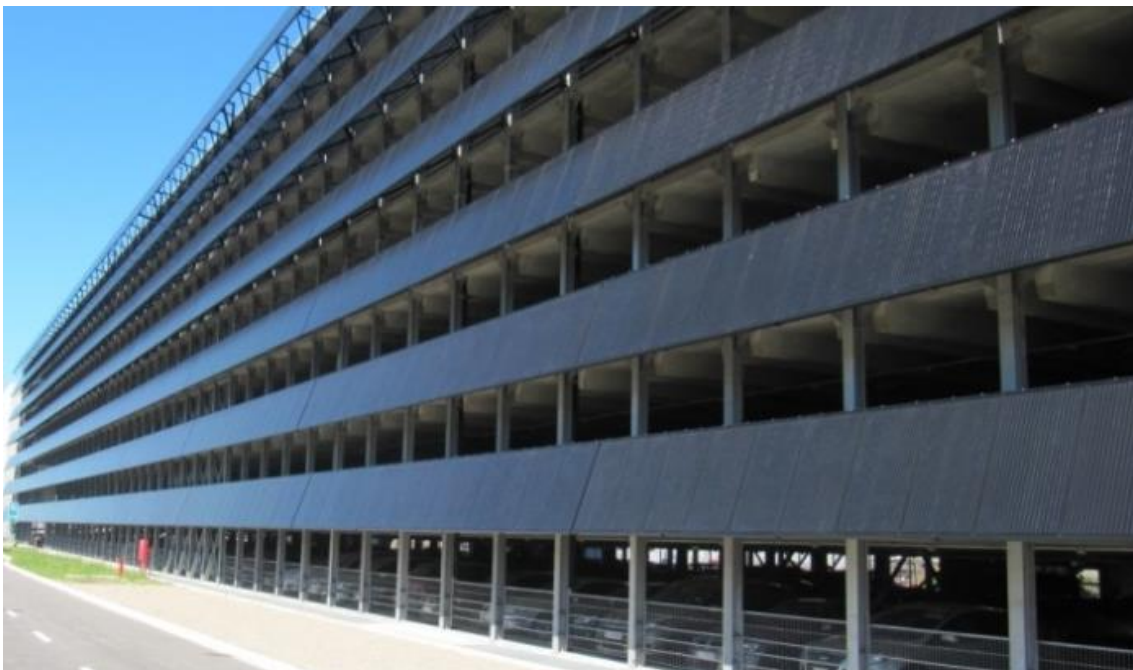
Abb. 37: Der Fassadenstromertrag des solaren Parkhauses Hoffmann-La Roche beträgt 140.2 kWh/m 2 a oder 95.7% des Dachsolarstromertrages von 146.5 kWh/m 2 a – ein Weltrekord (Werte bestätigt durch AEW Energie AG am 22.06.2017, Schweizer Solarpreis 2017, S. 90/91/378 E-Autos jährlich).
