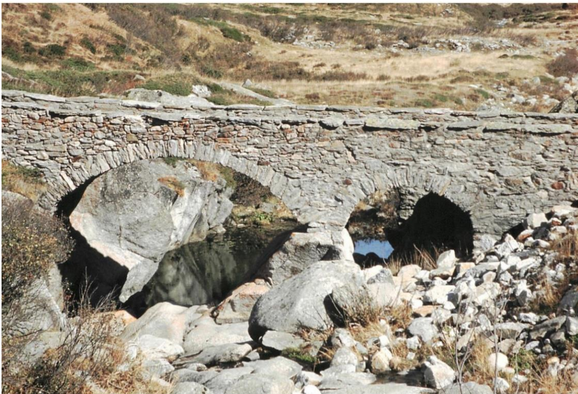
Abb. 31: Alte Steinbrücke am Lukmanierpass, Medelser Rhein von den Kraftwerken Vorderrhein (KVR/NOK/AXPO) trockengelegt/GR (Bild SGS Okt 2008)
