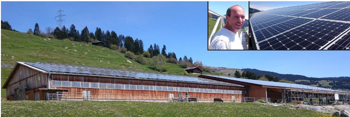
Abb. 33: 400 kW-starke PV-Anlage in Andiastr/GR, 1'300 m ü.M. erzeugt ca. 400'000 kWh/a.
