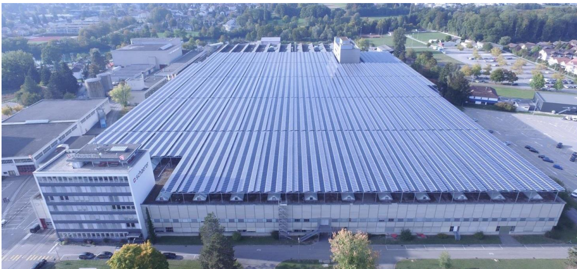
Abb. 44: Solarareal Riverside in Zuchwil/SO. Die 35'280 m 2 grosse PV-Anlage erzeugt jährlich 4'699'100 kWh und kann damit 60% des elektrischen Energiebedarfs der heute auf dem Areal domizilierten Unternehmungen decken (Werte bestätigt von AEK Energie AG am 17.07.2016, Tel. 032 634 88 88, Schweiz. Solarpreis 2016, S. 88/98).
