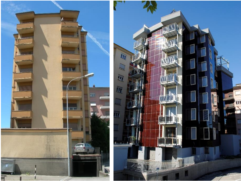
Abb. 20: 114%-PEB-MFH Palazzo Positivo Gasser von 1995 vor und nach der Sanierung 2018. Das achtstöckige MFH reduzierte den Energiebedarf von 502'900 kWh/a um 88% auf 62'500 kWh/a. Die PV Dach- und Fassadenanlagen generieren gut 71'100 kWh/a, die Eigenenergieversorgung beträgt 114% (Schweizer Solarpreis 2014/7 E-Autos jährlich). Energiebedarf vor San.: 502'920 kWh/a (100%) Eigenenergieversorgung: 71'122 kWh/a (114%) Energiebedarf nach San.: 62'459 kWh/a (12%) Solarstromüberschuss: 8'663 kWh/a (14%)
