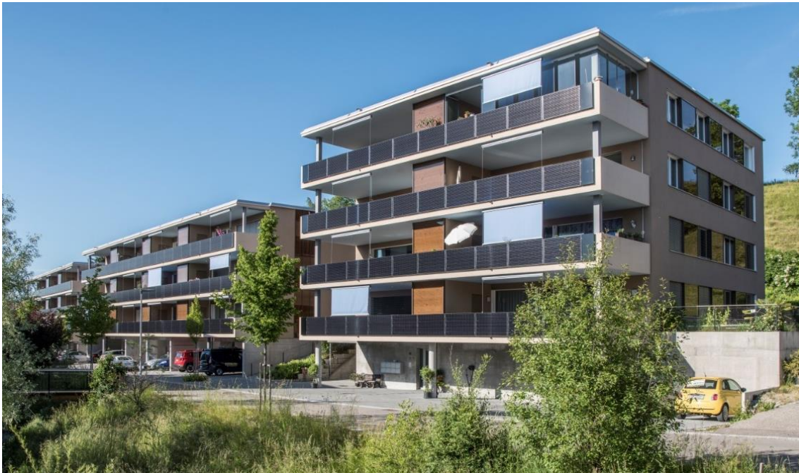
Abb. 17: PEB Siedlung Tobel mit 32 Wohnungen (Europ. und Schweizer Norman Foster-PEB Solarpreis 2019/77 E-Autos j.) Energiebedarf vor San.: 133'320 kWh/a (100%) Eigenenergieversorgung: 236'300 kWh/a (182%) Energiebedarf nach San.: 129'500 kWh/a (97%) Solarstromüberschuss: 106'800 kWh/a (82%)
