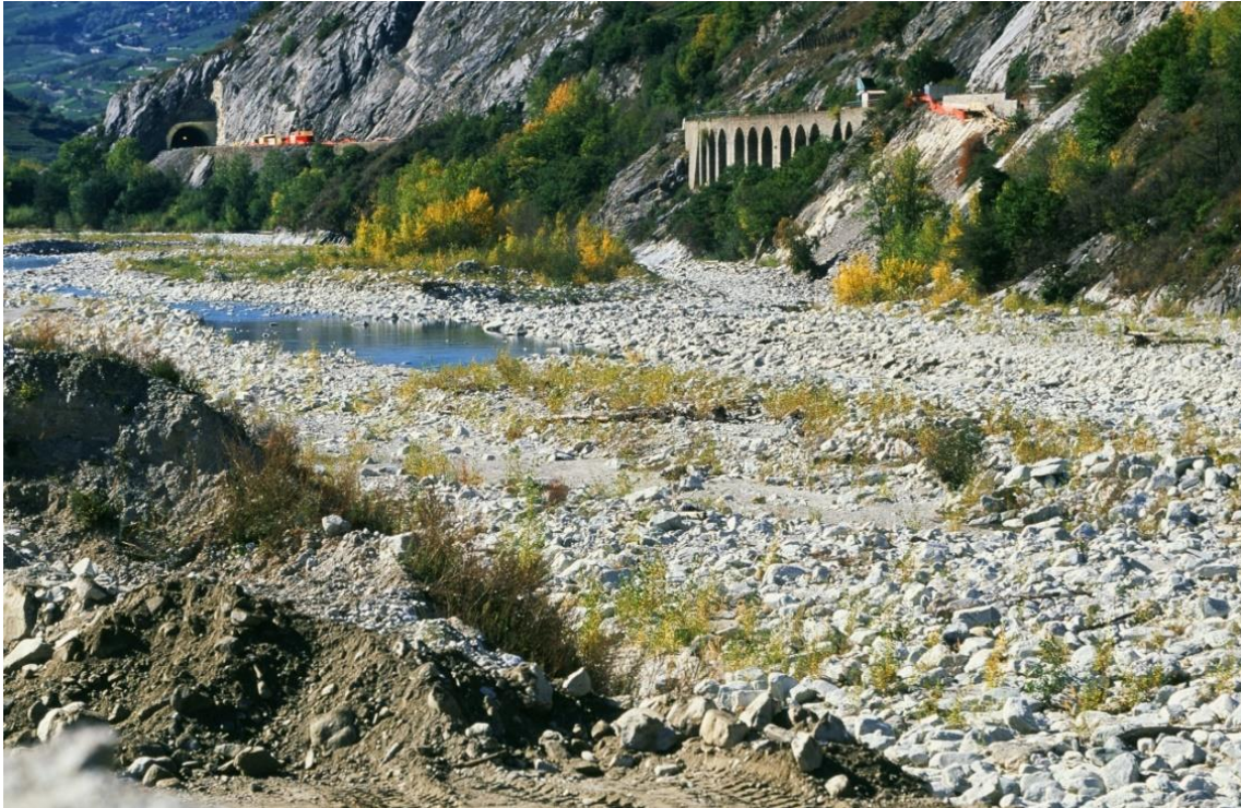
Abb. 26: Rotten bei Leuk/VS von den Rhonekraftwerken sehr stark genutzt (Bild SGS, Sommer 2008)
