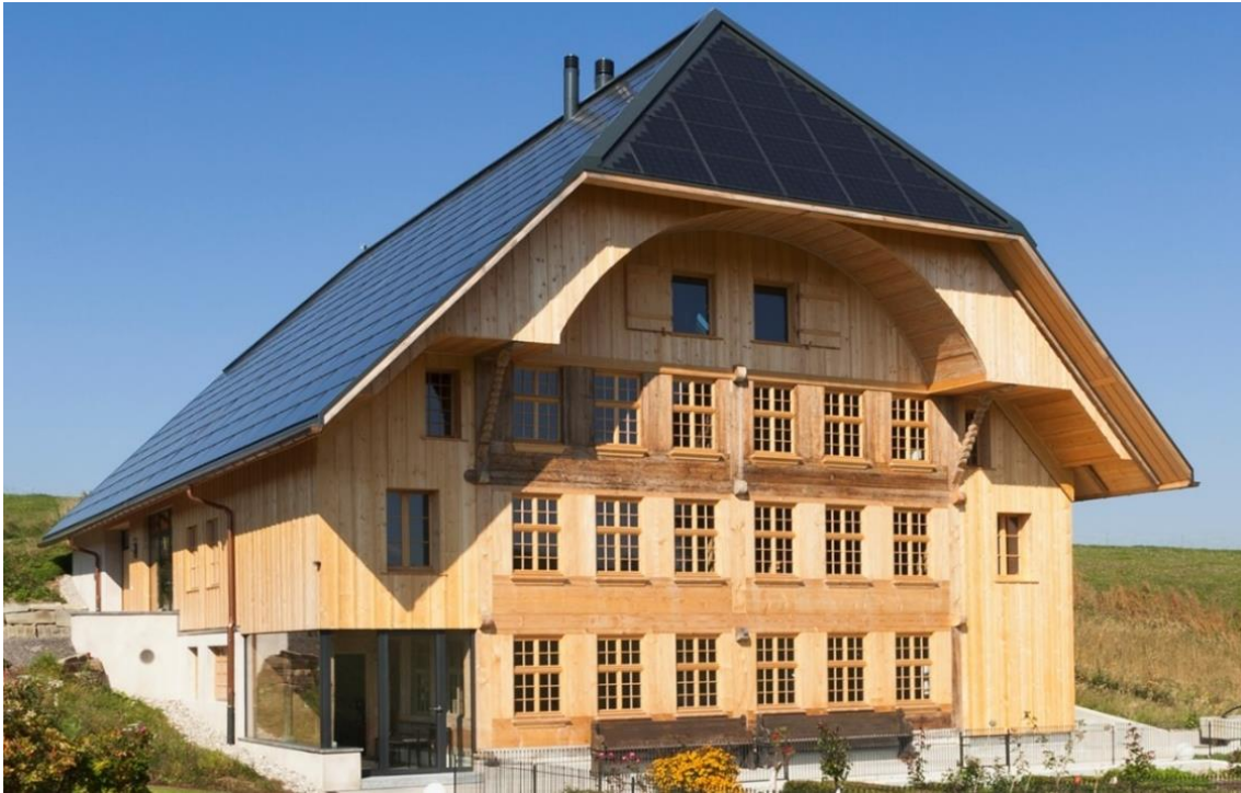
Abb. 16: PEB Sanierung Anliker von 1765 (PEB, Schweiz/Europ. Solarpreis 2016/46 E-Autos 12'000 km CO 2 -frei jährlich 33 ) Energiebedarf vor San.: 196'800 kWh/a (100%) Eigenenergieversorgung: 90'000 kWh/a (750%) Energiebedarf nach San.: 12'000 kWh/a (6%) Solarstromüberschuss: 78'000 kWh/a (650%)
