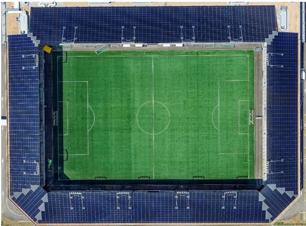
Abb. 47: Plus Energie - Fussballstadion in Schaffhausen (PEB Diplom und Schweizer Solarpreis 2017/307 E-Autos j.) Gesamtenergiebedarf: 860'467 kWh/a (100%) Solarstromüberschuss: 429'533 kWh/a (50%) Eigenenergieversorgung: 1'290'000 kWh/a (150%)
