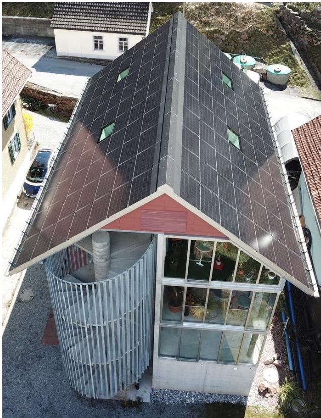
Abb. 24: PEB MFH Sanierung in Murg/SG (PEB Solarpreis 2019/3 E-Autos jährlich)
