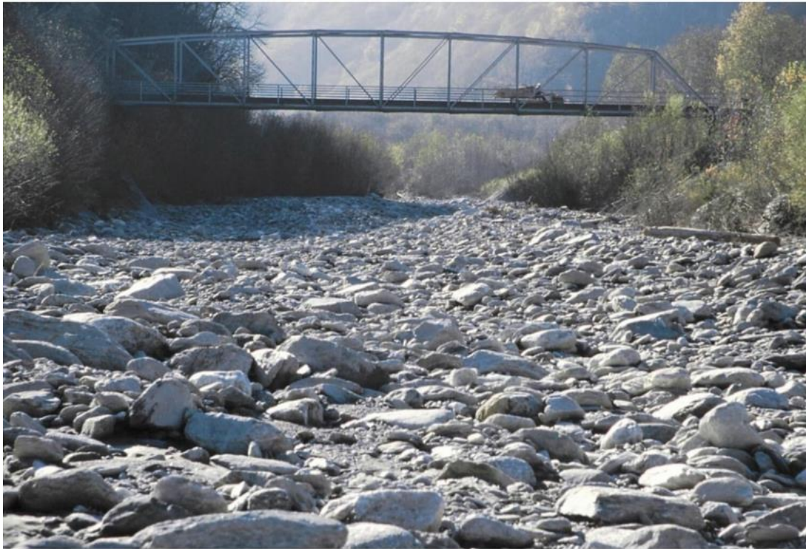
Abb. 17: Sumvitgerrhein/GR von den KVR/NOK/AXPO seit Jahrzehnten vollständig trockengelegt (Bild SGS, Okt 2008).
