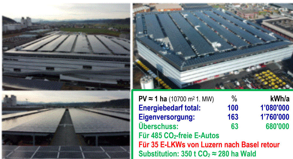
Abb. 27: Das PEB-Car House der Firma Galliker benötigt ≈ 1.08 GWh/a und erzeugt mit 1.97 MW PV-Anlage auf 10'700 m 2 1.76 GWh/a. Der Solarstromüberschuss von 680'000 kWh/a reicht für 485 Elektroautos, bzw. für eine Flotte von 35 Elektro-LKW um täglich CO 2 -frei von Luzern nach Basel retour zu fahren (PEB-Perlen: täglich 145 Camions LU-BS-LU).
