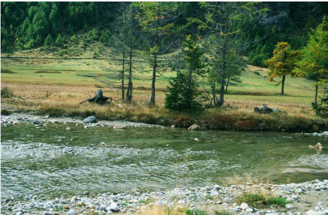
Abb. 4: Cavaglia/GR, vorbildlich renaturiert von der Rätia Energie AG
