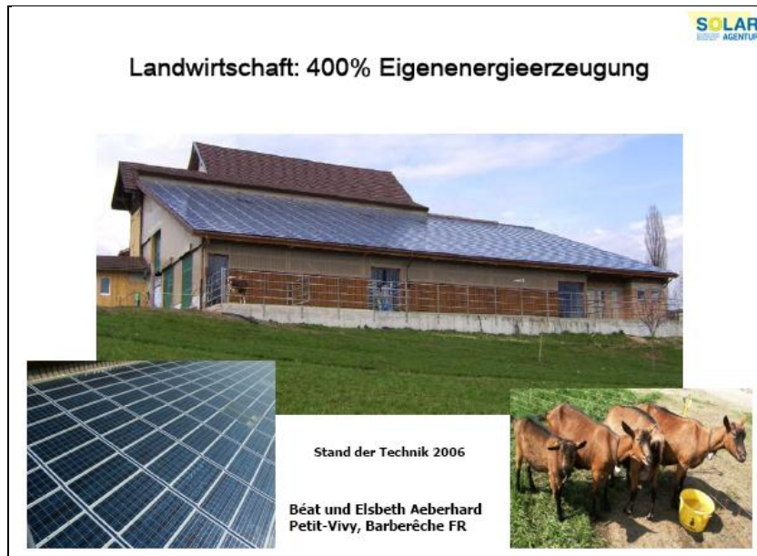
Abbildung 14: Landwirtschaftsbetrieb Aeberhard, Barbarèche/FR mit gemessenen 400% Eigenenergieerzeugung; Gesamtenergiebedarf für 45 GVE. 30'000 kWh/a; solare Jahreserzeugung vom 15. Nov. 2005 bis zum 15. Nov. 2006: 120'000 kWh, Europ. Solarpreis 2006 (Vgl. Abb. 2 und Schweiz. Solarpreis 2006 www.solaragentur.ch ); weniger als städtisches Vorbild, sondern vielmehr als Beispiel wie Dächer von Garagen, Sporthallen, Spitälern, Hochschulbauten, Lagergebäuden etc. genutzt werden können.
