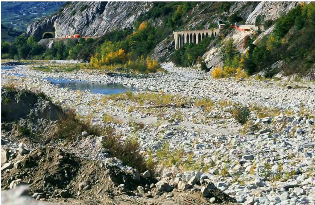
Abb. 31: Rotten bei Leuk/VS von den Rhonekraftwerken sehr stark genutzt (Bild SGS, Sommer 2008)
