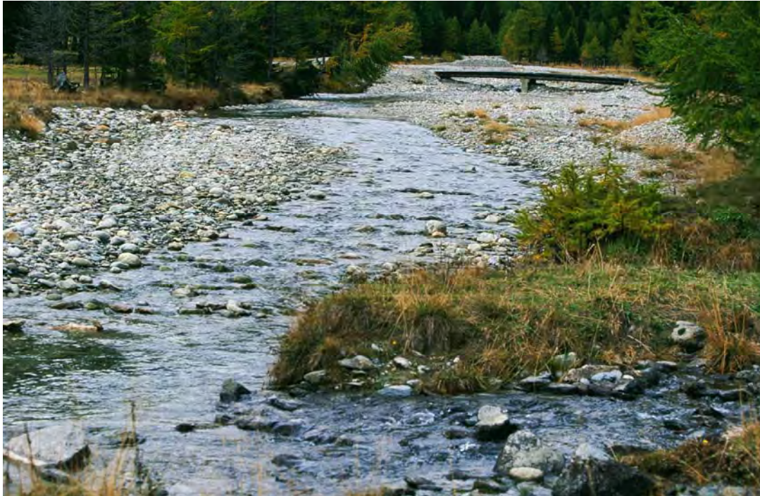
Abb. 7: Vorbildliche Sanierung der Cavaglia durch die Rätia Energie AG/GR (Bild SGS)
