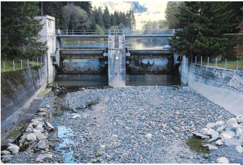
Abb. 41: KVR/NOK Stauwehr bei Sedrun/GR, Bild SGS Oktober 2008
