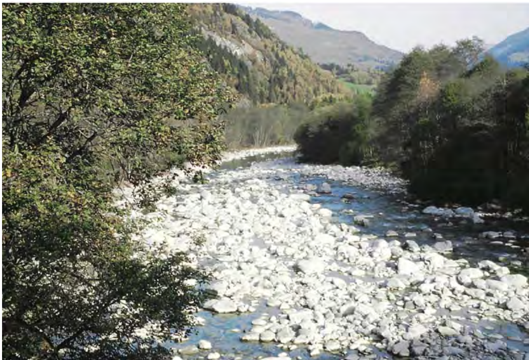
Abb. 18: Hinterrhein bei Andeer/GR von den Kraftwerken Hinterrhein (KHR/NOK/AXPO) fast trockengelegt. (Bild SGS, Okt 2008)
