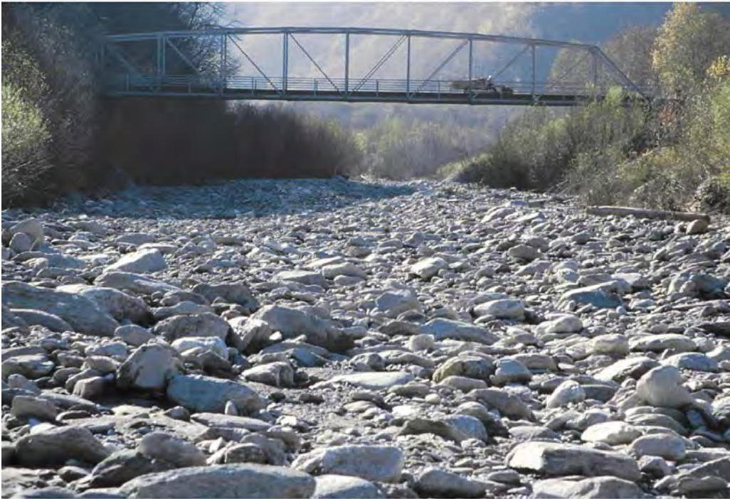
Abb. 21: Sumvitgerrhein von den KVR/NOK/AKPO seit Jahrzehnten vollständig trockengelegt/GR (Bild SGS, Okt 2008)
