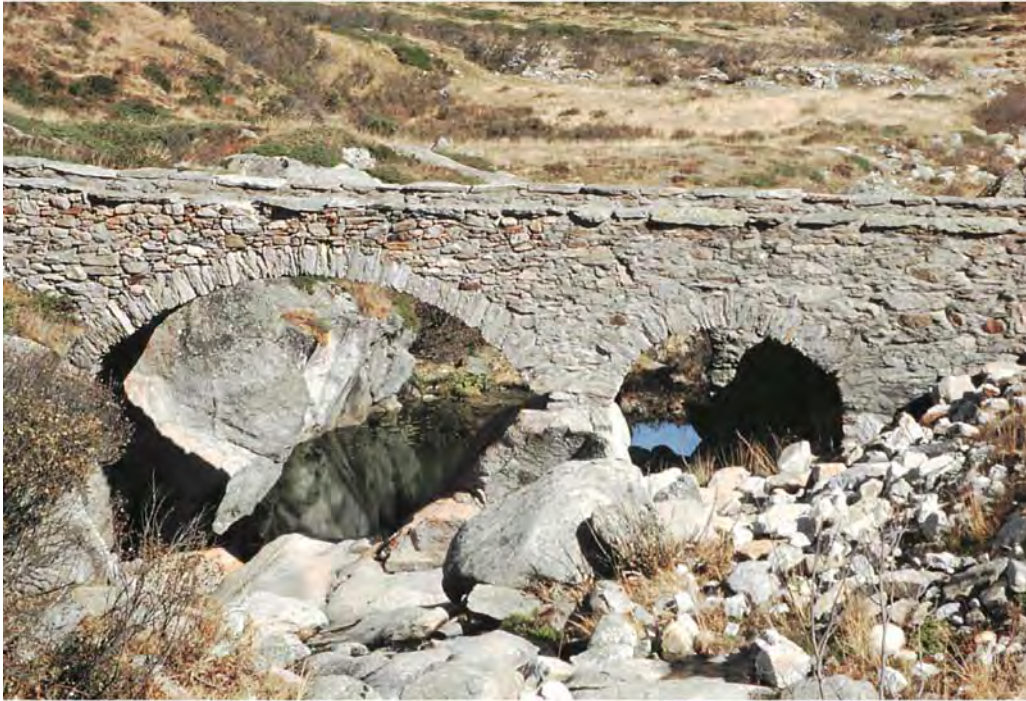
Abb. 11: Alte Steinbrücke am Lukmanierpass, Medelser Rhein von den Kraftwerken Vorderrhein (KVR/NOK/AXPO) trockengelegt/GR (Bild SGS Okt 2008)
