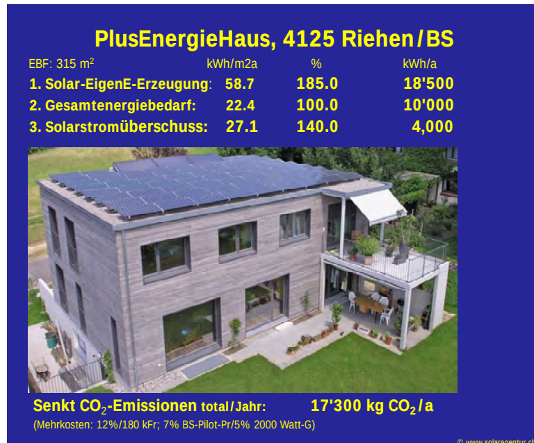
Abb. 5: PlusEnergieHaus für 2 Familien mit Schweiz. Solarpreis 2008 ausgezeichnet in Riehen/BS mit einer solaren Eigenenergieerzeugung von 18'500 kWh/a, einem jährlichen Gesamtenergiebedarf von 10'000 kWh/a und einem Solarstromüberschuss von ca. 4'000 kWh/a für's öff. Netz.
