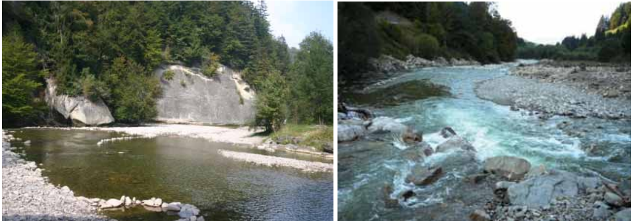
Abb. 9a und 9b: Teilabschnitt der Warmen Sense. Hier soll ein neues Wasserkraftwerk entstehen.
