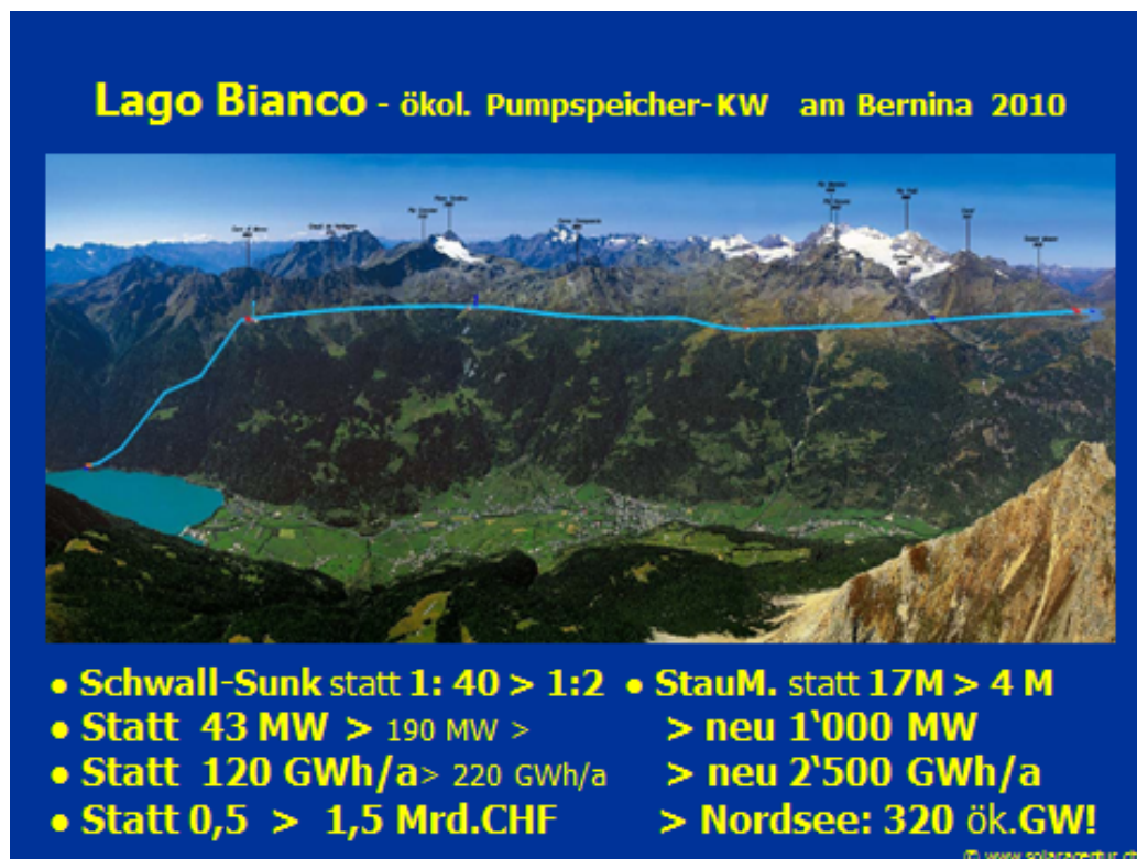
Abb. 38: Neues Pumpspeicherwerk Lago Bianco am Bernina: Die SGS prüft und unterstützt seit 2004 die ökologischen Pumpspeicherkraftwerke, wie 2007 der Rätia Energie vorgeschlagen.
