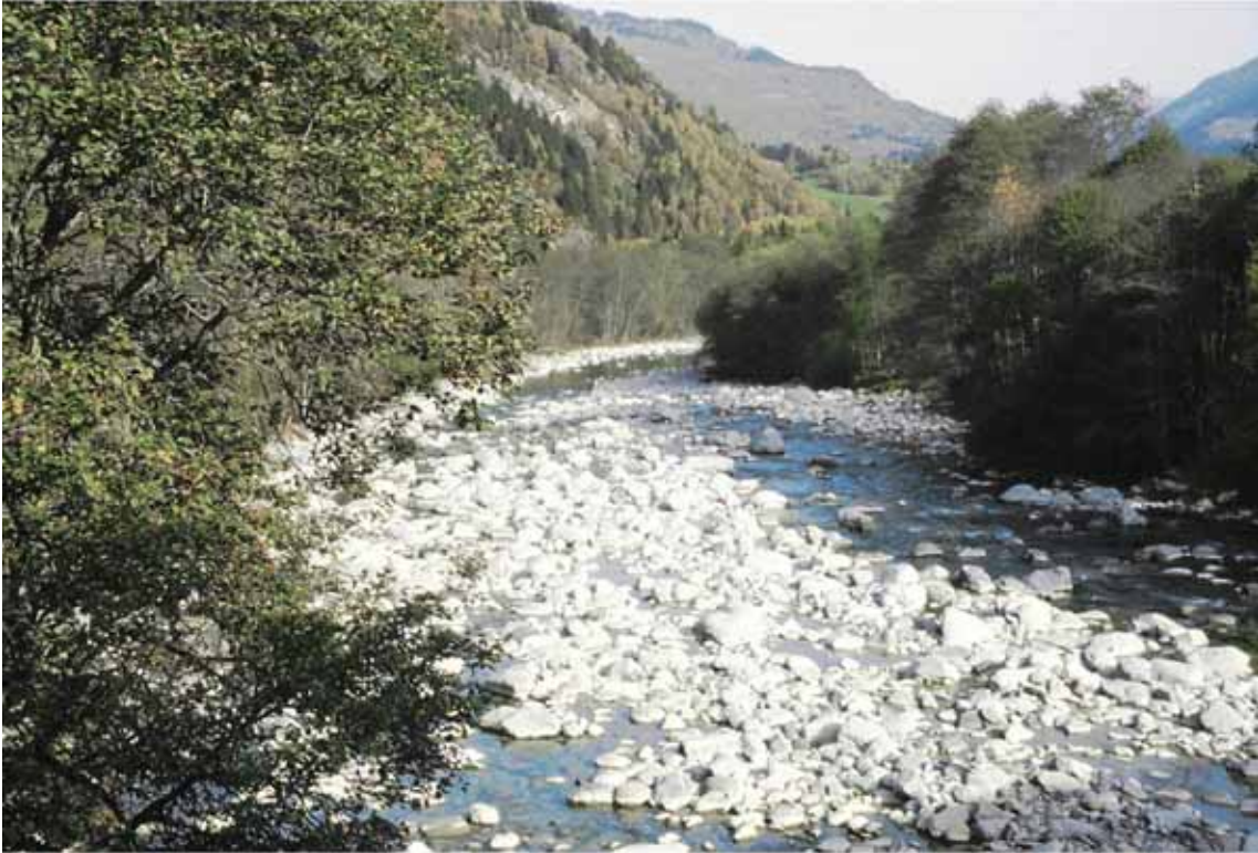
Abb. 24: Hinterrhein bei Andeer/GR von den Kraftwerken Hinterrhein (KHR/NOK/AXPO) fast trocken gelegt. (Bild SGS, Okt 2008).
