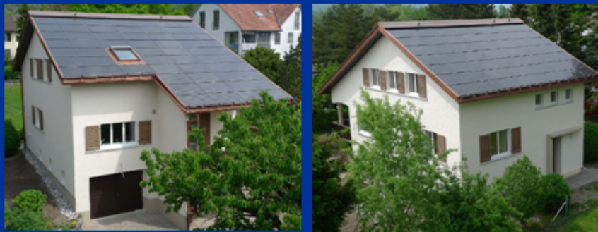
Abb. 4: Dieser PEB, ein saniertes Arbeiterhaus von 1953 in Vaduz, liegt nach der Sanierung 190% unter den Vorgaben der 2000-Watt-Gesellschaft. Vorher benötigte es 52'000 kWh/a; nach der Sanierung noch 7'000 kWh/a für den Gesamtenergiebedarf (Warmwasser, Heizung inkl. den gesamten Haushalts- und Betriebsstrom). Es erzeugt aber 12'700 kWh/a und kann damit noch 3-4 Elektrofahrzeuge solar betreiben.
