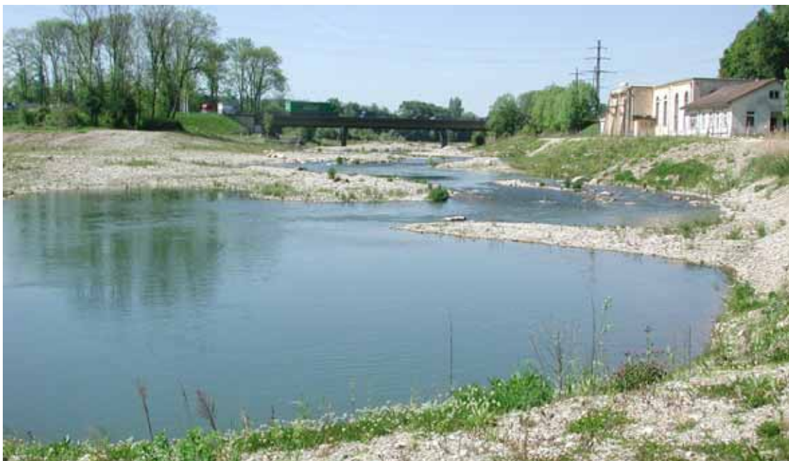
Abb. 17: Das mäandrierende Umgehungsgewässer des KW Ruppoldingen der Alpiq bei Olten.
