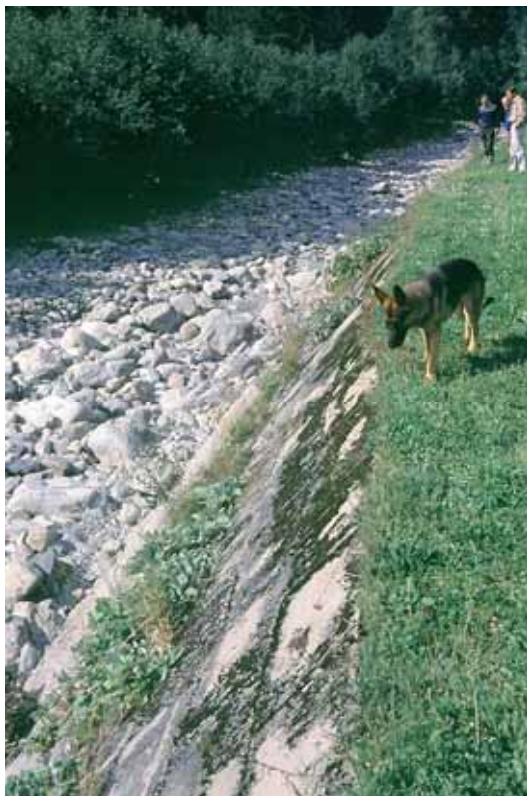
Abb. 32: Gadmerwasser Steinwasser Oberland Ost Kt Bern praktisch trocken gelegt durch die KWO (Bild Roth/ BE).
