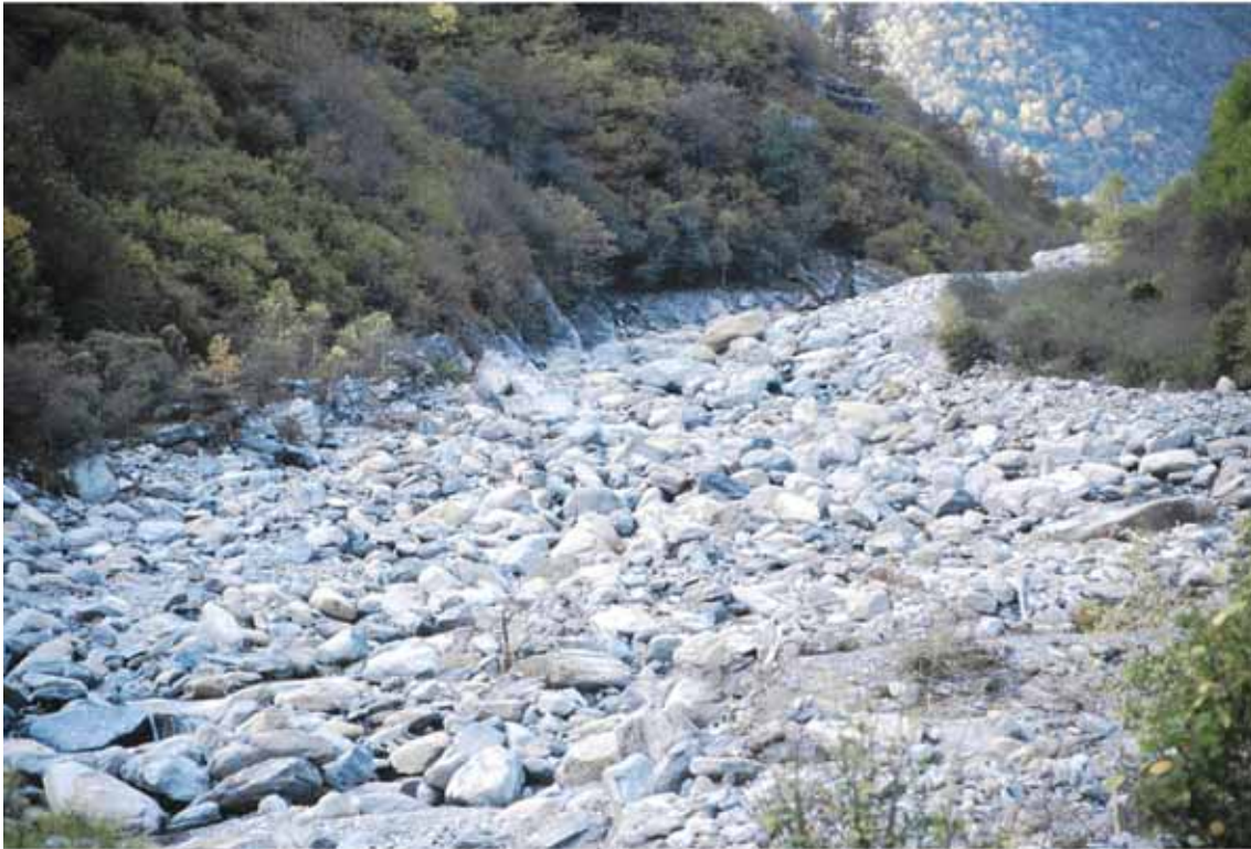
Abb. 35: Brenno oberhalb Olivone/TI. Die Nutzung des Brenno oberhalb Olivone ist an ein Partnerwerk namens Officine idroelettriche Blenio SA (OFIBLE) konzidiert. Daran beteiligt sind der Kanton Tessin (1/5), ATEL, NOK, Stadt Zürich (je 1/6), Kanton Basel Stadt und BKW (je 1/8) und die Städtischen Werke Bern (1/20). (Bild SGS Okt. 2008). Praktisch trocken gelegt.
