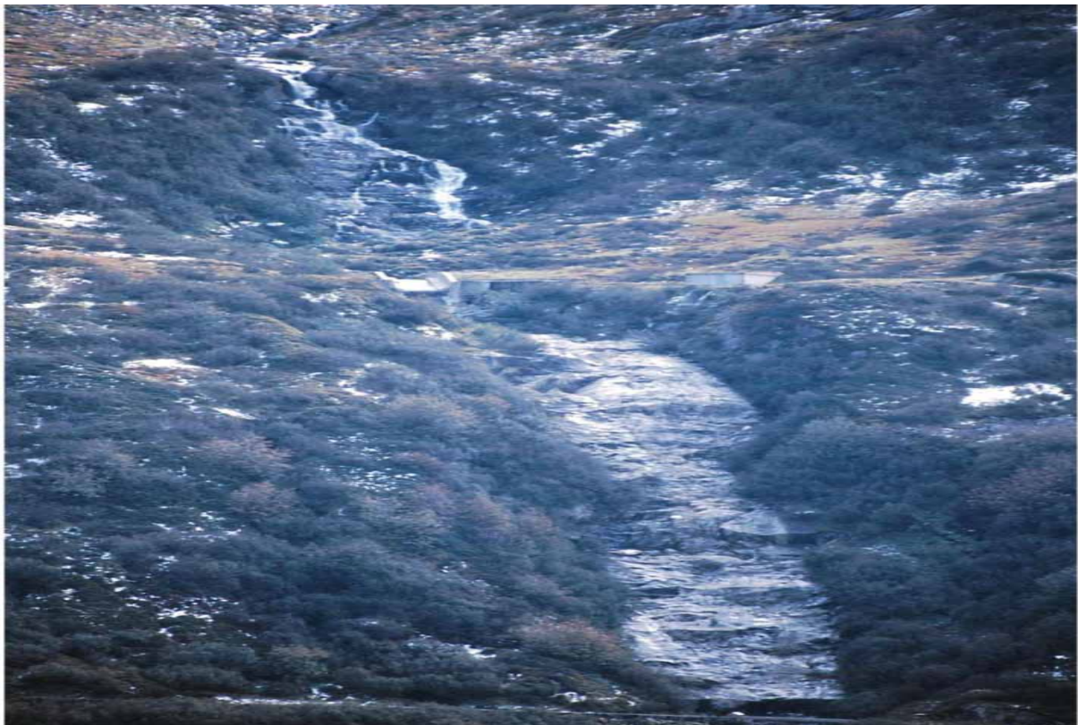
Abb. 40b: Einzugsgebiet Oberalp an der Wiege des Vorderrheins: Oben fliesst noch ein Bächlein ins Tal – doch es wird von der KVR/NOK/AXPO vollständig gefasst und trockengelegt, wie in der unteren Bildhälfte ersichtlich. (Bild: SGS, Oktober 2008).
