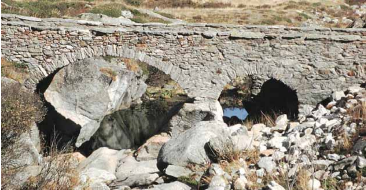
Abb. 32: Alte Steinbrücke am Lukmanierpass, Medelser Rhein von den Kraftwerken Vorderrhein (KVR/NOK/AXPO) trockengelegt/GR (Bild: SGS, Oktober 2008).
