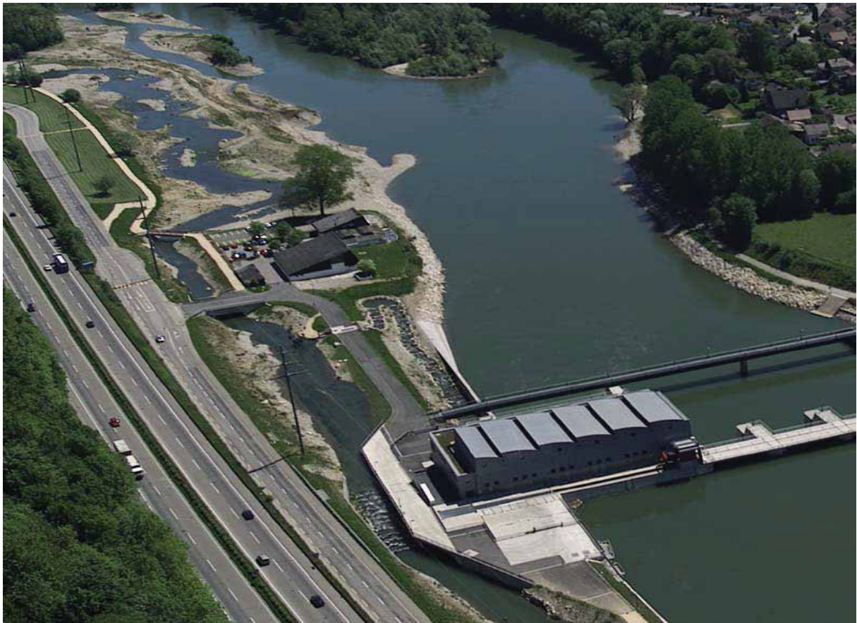
Abb. 31c: Dank minimalen Anpassungen des KW Ruppoldingen der Alpiq bei Olten konnten hier die Lebensräume für Fische und andere Wassertiere erheblich verbessert werden. (Bild: Alpiq).
