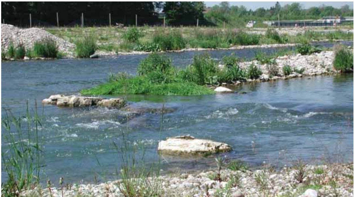
Abb. 31a: Vorbildliche Flusssanierung des KW Ruppoldingen der Alpiq bei Olten mit angemessener Restwassermenge und mäandrierendem Umgehungsgewässer. (Bild: Alpiq).
