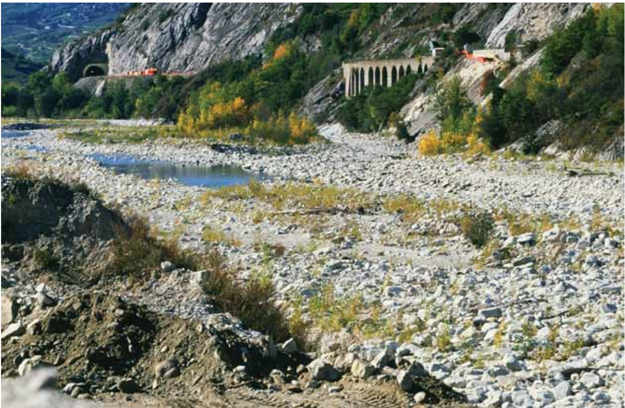
Abb. 48: Rotten bei Leuk/VS von den Rhonekraftwerken sehr stark genutzt. (Bild SGS, Sommer 2008).
