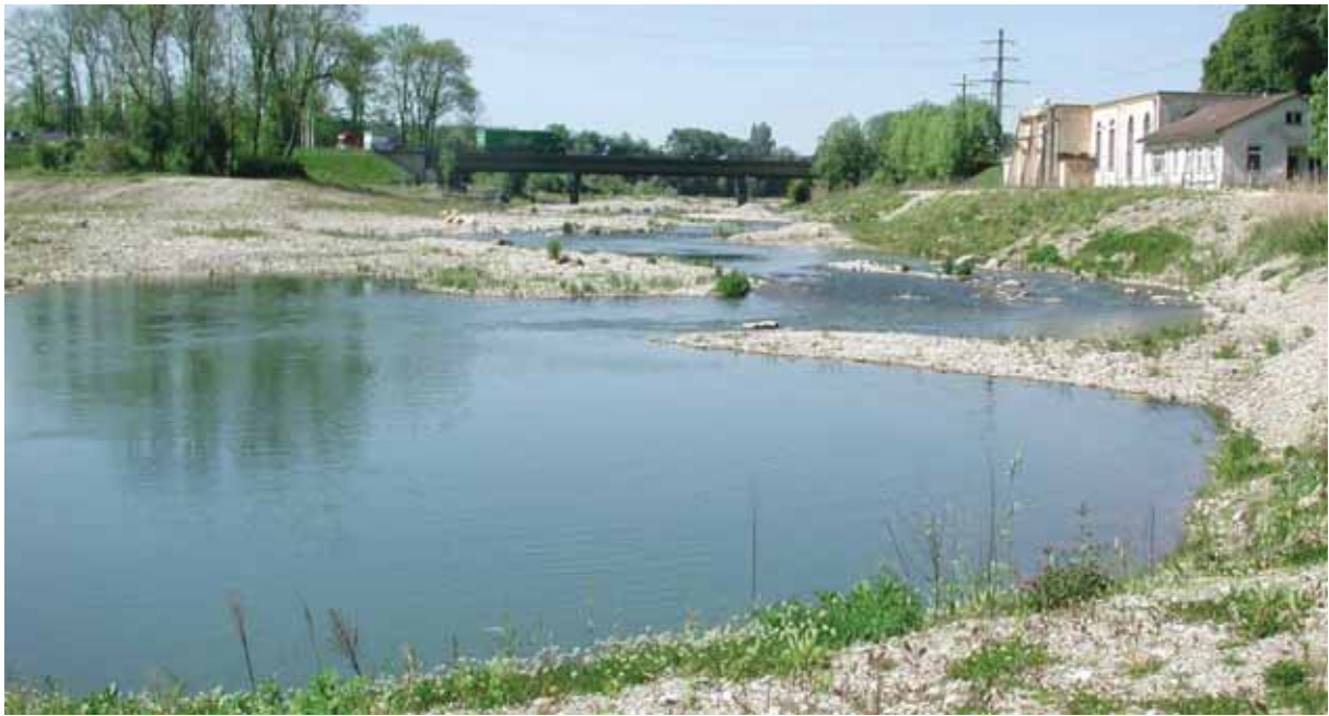
Abb. 31b: Vorbildliche Flusssanierung des KW Ruppoldingen der Alpiq bei Olten mit angemessener Restwassermenge und mäandrierendem Umgehungsgewässer. Die Lebensräume für Fische und andere Wassertiere wurden erheblich verbessert. (Bild: Alpiq).
