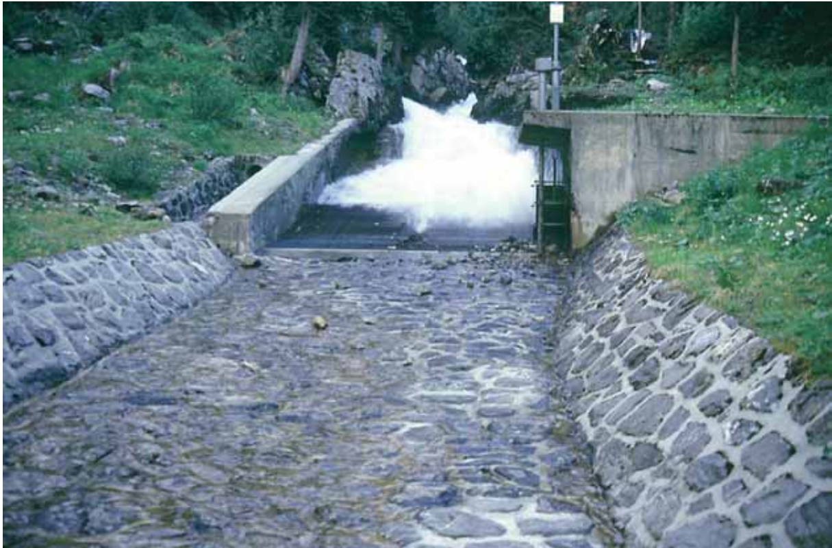
Abb. 42: Engstlenbach Oberland Ost Kt Bern, von KWO vollständig gefasst und dann trockengelegt. (Bild: Roth/BE).
