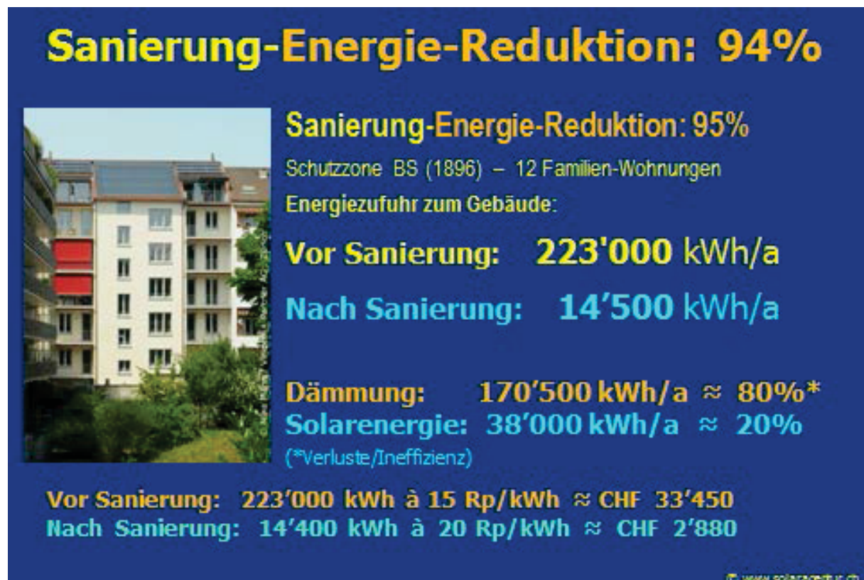
Abb. 20: Reduktion der Fremdenergiezufuhr um 94% (Kosten ≈ 89%) bei einer MFH-Sanierung einer Altstadtliegenschaft mit Baujahr 1896 in der Schutzzone von Basel (2012).
