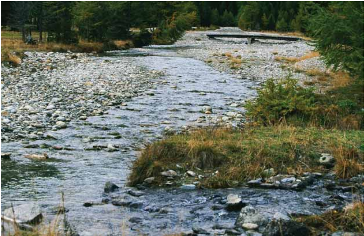
Abb. 29b: Vorbildliche Sanierung der Cavaglia durch die Rätia Energie AG/GR (Bild: SGS).
