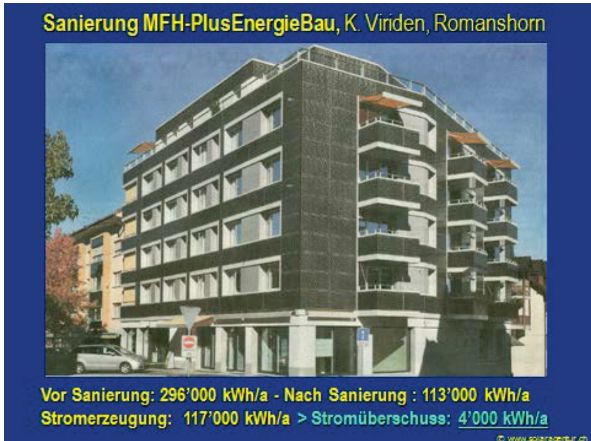
Abb. 22: Fünfstöckige MFH-PlusEnergieBau-Sanierung in Romanshorn/TG, NZZ, 4.1.2013.
