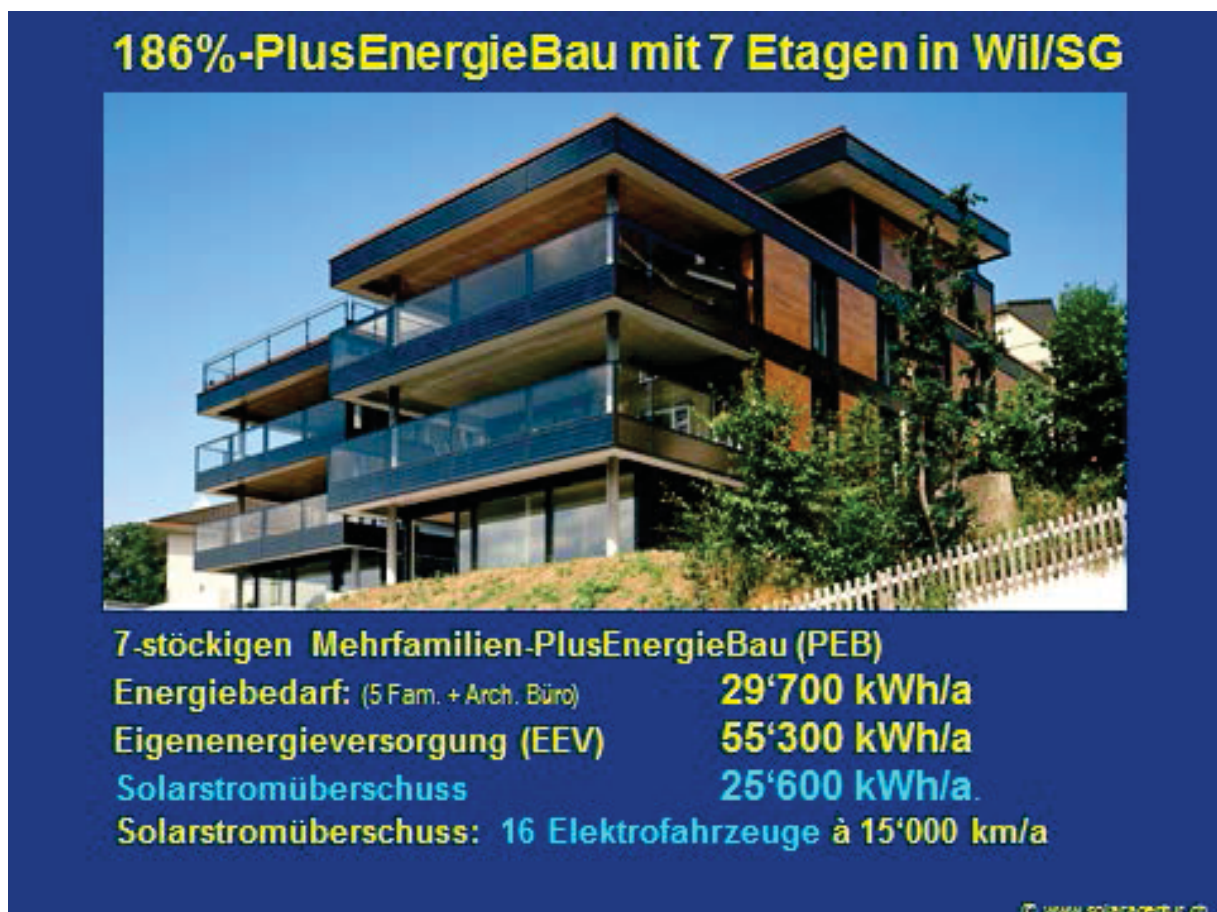
Abb. 21: Siebenstöckiger PEB-Wohn- und Geschäftsbau in Wil/SG mit einer Eigenenergieversorgung von 186%. Der Stromüberschuss beträgt 25'600 kWh/a (Schweiz. Solarpreis 2012).
