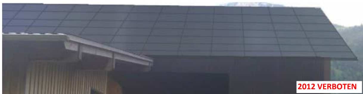
Abb. 25: Diese sorgfältig integrierte Solaranlage darf aufgrund des ISOS-Begriffs nicht gebaut werden, weil sie angeblich ein 40 m entferntes Bauernhaus beeinträchtigt. Die Anlage würde etwa 80'000 kWh/a generieren. (Bild: Solar Agentur Schweiz)
