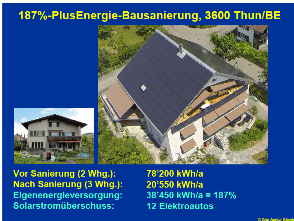
Abb. 15: Dieses Mehrfamilienhaus in Thun/BE konsumierte vor der Sanierung mehr als 78'000 kWh/a. Heute benötigt es noch gut 20'600 kWh/a und erzeugt zusätzlich 38'500 kWh/a. Die Eigenenergieversorgung beträgt 187%, trotz Ausbau von 2 auf 3 Wohnungen. (Schweizer Solarpreis 2013, S. 54-55)
