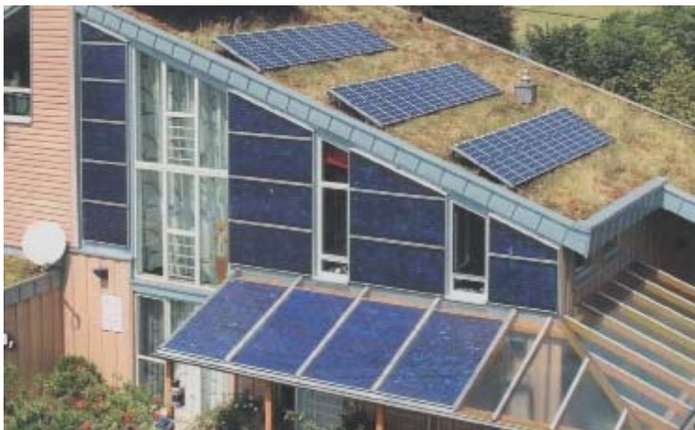
Abb. 23: Viele Denkmalpflegebeamte und Politiker im Nationalrat stellen sich die Solarnutzung so vor. Optischer und energetischer Unsinn. Hätte man bei diesem Bau auf eine sorgfältige Integration der PV-Module geachtet, könnte mehr Strom erzeugt werden und das Haus wäre nicht so hässlich anzusehen. Solche Anlagen will die neue RPV gemäss Art. 32a Abs. 1 lit a zulassen! Eine unprofessionelle Gesetzgebungsarbeit der NR-UREK. (Bild: Photon)
