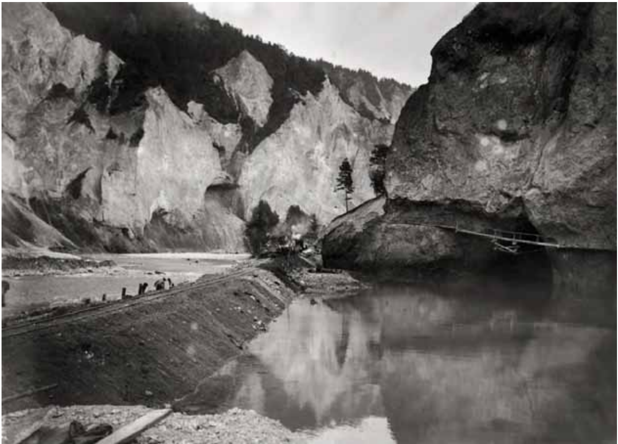
Abb. 35: Bau der Bahnlinie der Rhätischen Bahn (RhB) durch die Rheinschlucht in den Jahren 1910-1912.
