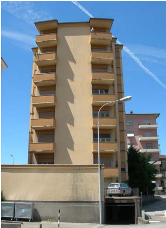
Abb. 38: Ansicht und Energiebedarf des 114%-PEB-MFH Palazzo Positivo Gasser in Chiasso/TI vor und nach der Sanierung. Das 1965 erstellte achtstöckige MFH reduzierte den bisherigen Energiebedarf von 502'900 kWh/a um 88% auf 62'500 kWh/a . Die PV-Dach- und Fassadenanlagen generieren gut 71'100 kWh/a und sorgen für eine Eigenenergieversorgung von 114% . (Bestätigt von age am 30.6.2014, Tel.: 091 695 07 21, Schweizer Solarpreis 2014, S.64/65).
