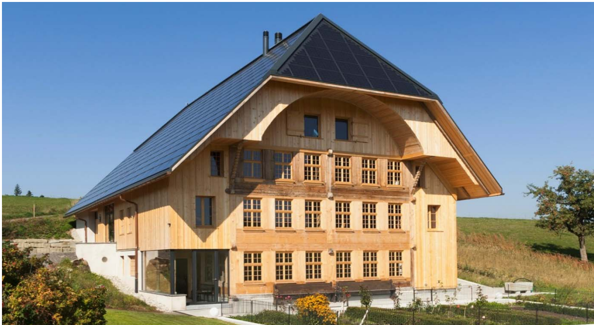
Abb. 45: Die Motion von Nationalrat Leo Müller setzt auf eine ökonomisch effiziente Energiewende im Gebäudebereich mit milliardenschwerer Wertschöpfung im Inland (PEB-Sanierung Anliker, 3416 Affoltern i.E./BE).
