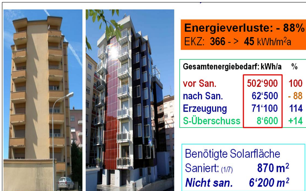
Abb. 25: Das 1965 erstellte, 2014 sanierte achtstöckige MFH-Hochhaus reduzierte den bisherigen Energiebedarf von 503'000 kWh/a um 88% auf 62'500 kWh/a . Die PV-Dach- und Fassadenanlagen generieren gut 71'100 kWh/a und sorgen für eine Eigenenergieversorgung von 114% . (Bestätigt von age am 30.6.2014, Schweizer Solarpreis 2014, S.64/65).
