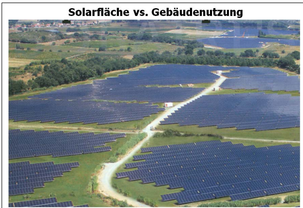
Abb. 31: Auf grüner Wiese müssten wegen der täglichen und saisonalen Verschattungsauswirkungen grössere Distanzen zu den aufgeständerten „Solartrocknern“ beachtet werden; d.h. rund 18'700 m 2 an Stelle der ca. 700 m 2 beim PEB-Sanierten MFH (Abb. 25). Das PEB-sanierte MFH benötigt dadurch 26.7 Mal weniger Landschaftsflächen.
