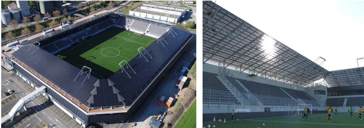
Abb. 19a und 19b: PEB-Fussballarena in Schaffhausen. Die 1.4 MW starke PV-Anlage deckt mit den erzeugten 1'290'000 kWh/a 150% des Gesamtenergiebedarfs des Stadions und des integrierten Einkaufs- und Gewerbezentrums. Die multifunktionale, vorbildlich integrierte PV-Anlage ist dank transluziden monokristallinen Solarzellen lichtdurchlässig und bietet den Fussballfans Schutz vor Witterung. Mit dem Solarstromüberschuss von 429'500 kWh/a können 307 Elektroautos jährlich 12'000 km CO 2 -frei fahren.
