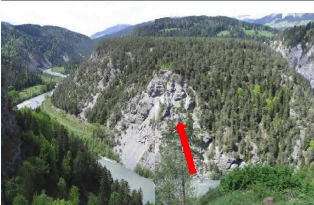
Abb. 22: Vorschlag für den Wanderweg durch das Auerhuhnschutzgebiet oberhalb des RhB-Ransuntunnels (Quelle: AJF GR, 25. Okt. 2013)
