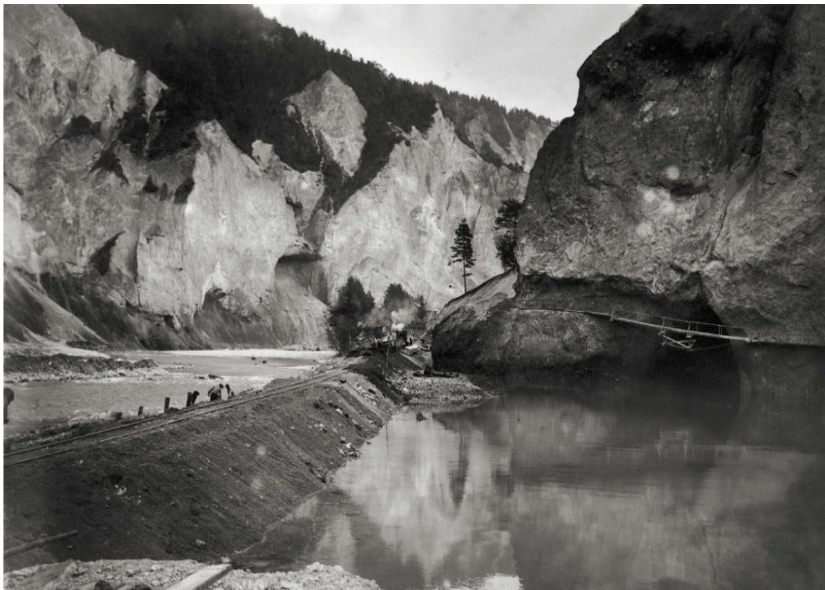
Abb. 24: Bau der Bahnlinie der Rhätischen Bahn (RhB) durch die Rheinschlucht in den Jahren 1910 - 1912.
